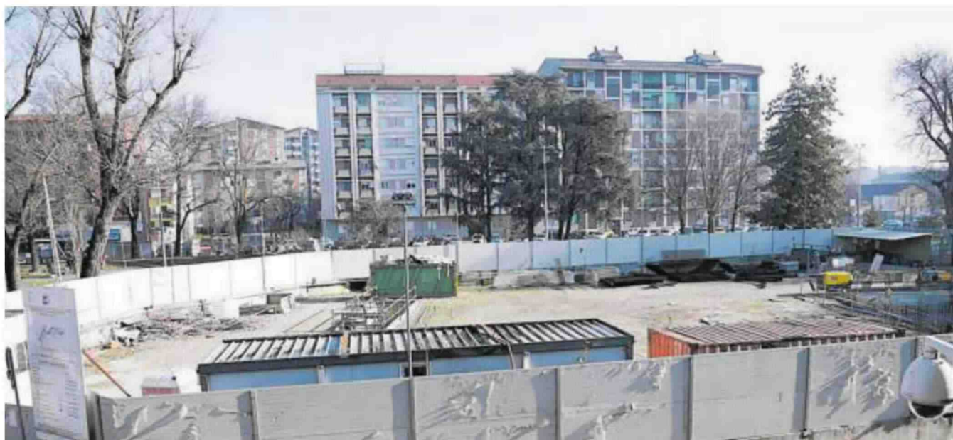
▲ Tutto fermo Dopo la tragedia di lunedì il cantiere della M4 è chiuso DUILIO PIAGGESI / FOTOGRAMMA
